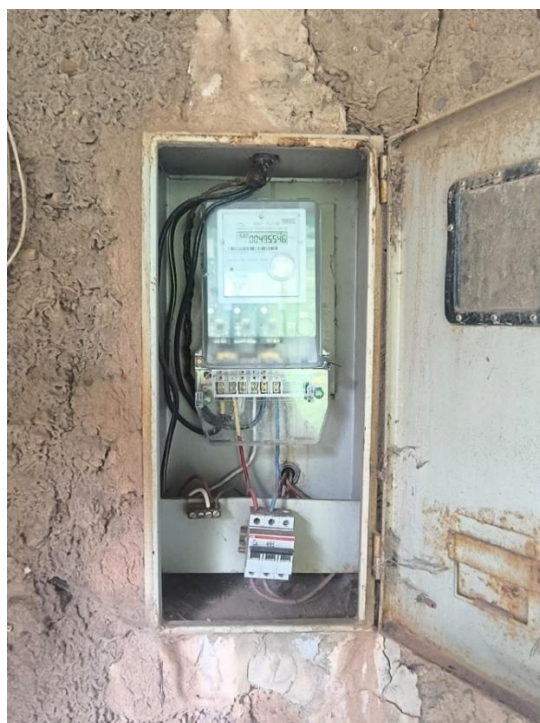
Foto 14: Medidor electrónico monofásico trifilar.
