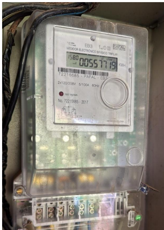
Foto 13: Medidor electrónico monofasico trifilar ubicado en la parte externa de la vivienda.
